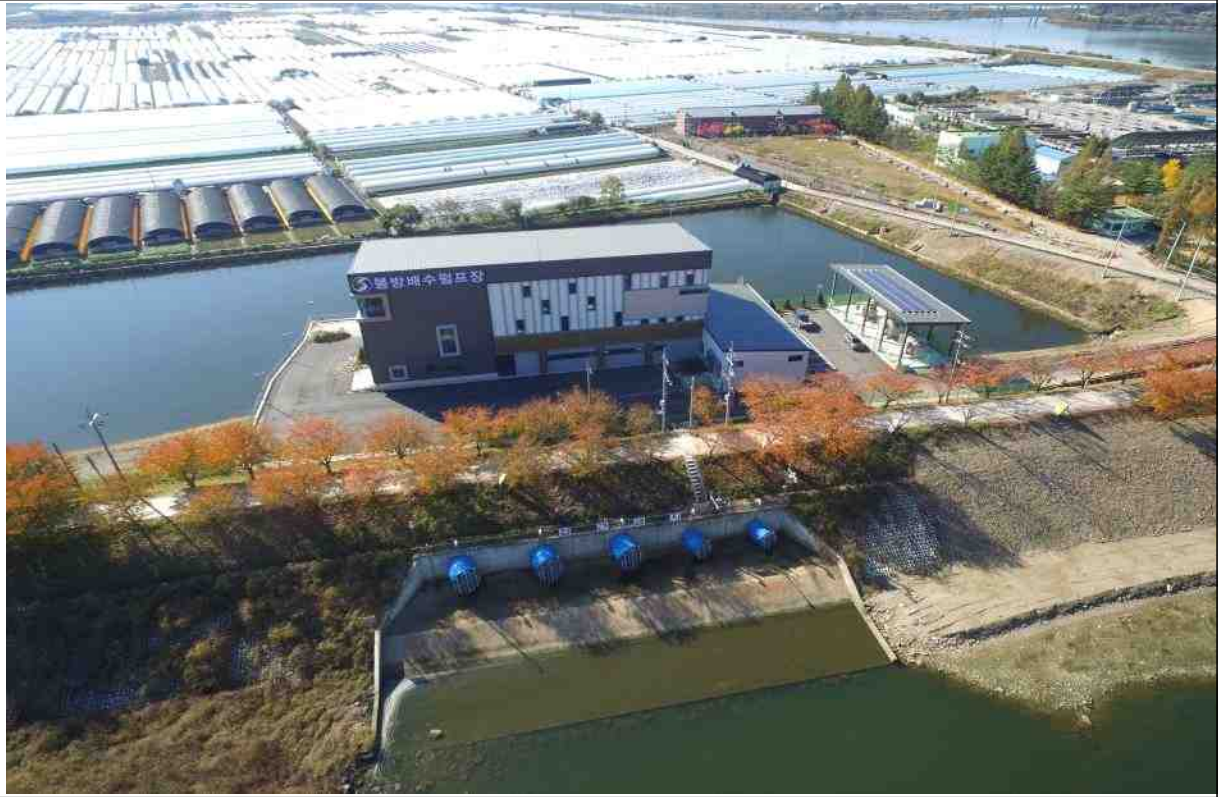
봉방 배수펌프장 증설완료(충주시 봉방동)
